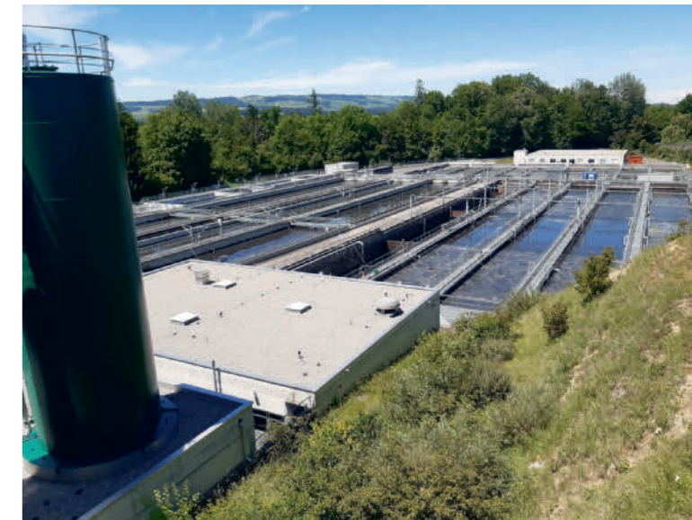
Über der ARA Schönau könnte ein Solarfalldach entstehen.
