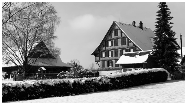
Durch den Entscheid des Regierungsrates vom 15. Januar 2019 kann das 400-jährige Bauernhaus Letzi 1 in Zug abgebrochen werden. Weitere Entlassungen werden folgen.
